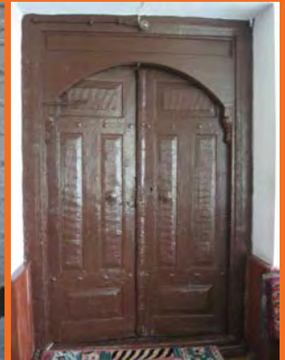
Hatipoğlu Camii Giriş Kapısı
