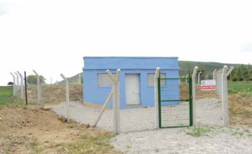
Bakım ve onarımı yapılan su depoları koruma altına alındı
