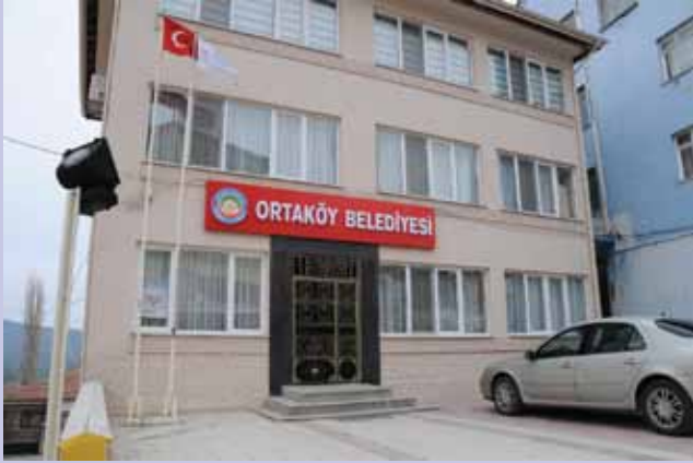
Belediye hizmet binası bakım onarımı yapılarak hizmete sunuldu
