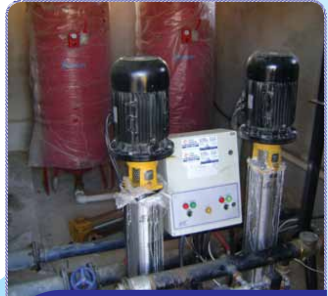
İçme suyu ilave çalışmaları doğrultusunda sondaj çalışmaları yapılmış, 28 lt/sn olan içme ve kullanma suyu 58 lt/sn ye çıkartılmıştır.
