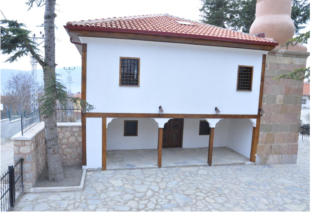
ÜÇ KÖY CAMİSİ RESTORASONU (DIŞ KISIM)
