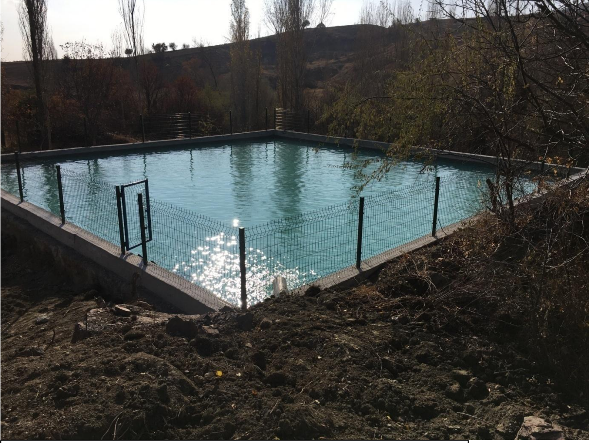
Merkez İsmail Köyü İç Havuz ve Havuzdan Damla Sulama Tesisi Yapımı
