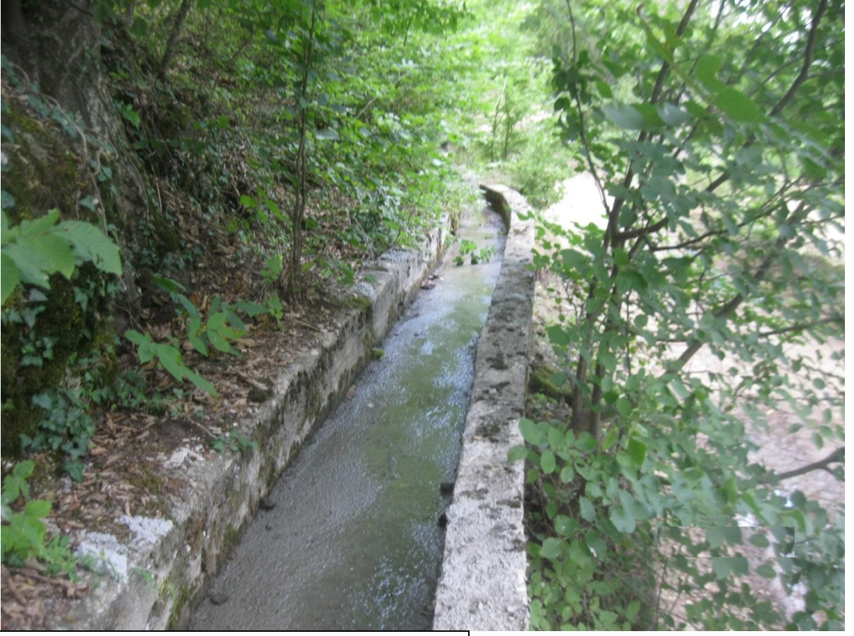
Çorum Dodurga İlçesi Sulama Kanalı Tesisi Yapımı
