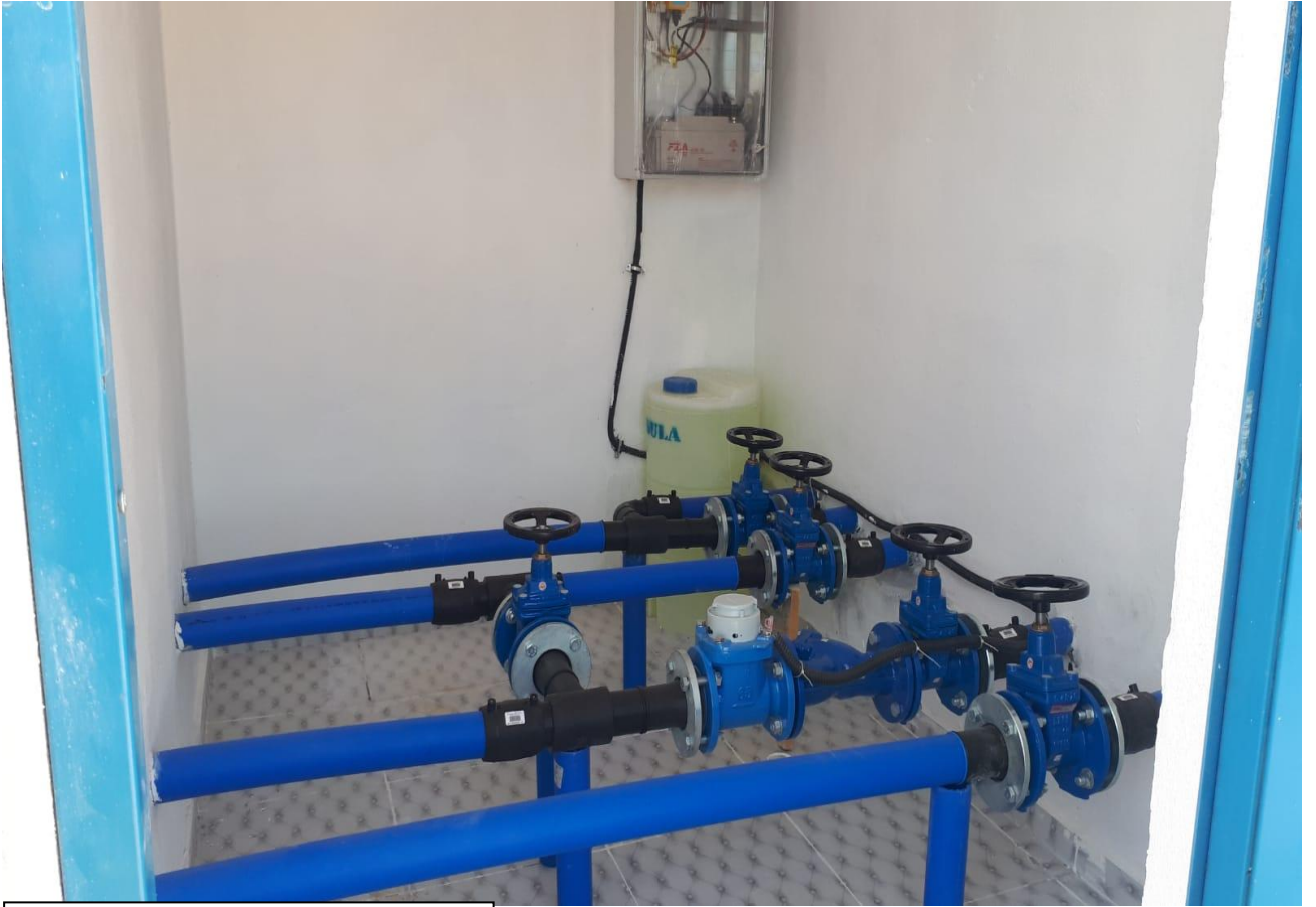
Merkez Kazıklıkaya Terfi Binası
