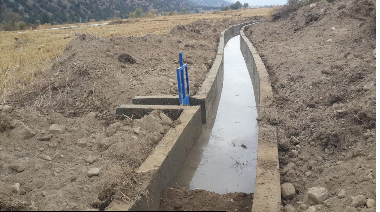
Çorum Kargı İlçesi Karaboya Köyü Sulama Kanalı Yapımı
