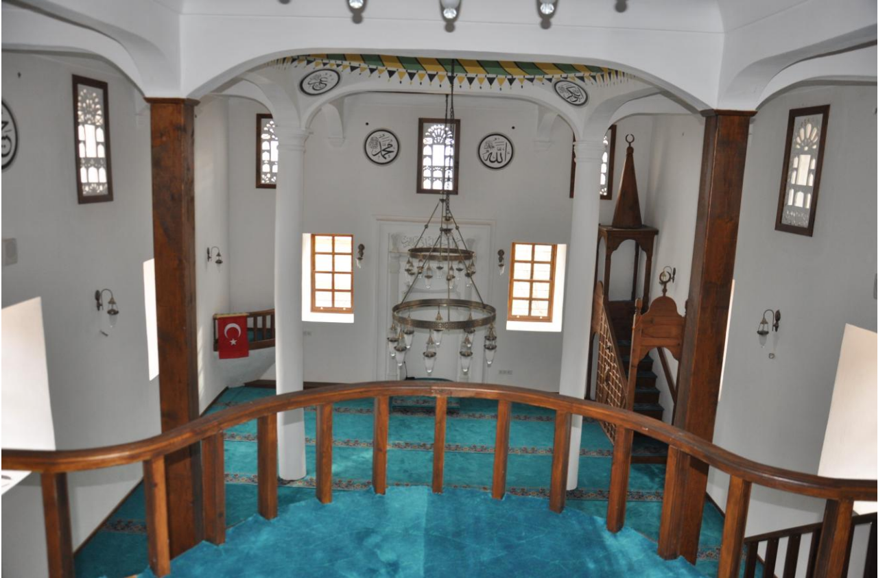
ÜÇ KÖY CAMİSİ RESTORASYONU (İÇ KISIM)
