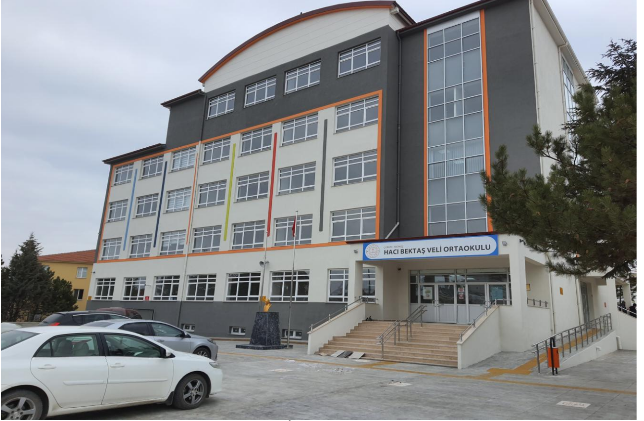
ÇORUM MERKEZ HACI BEKTAŞ VELİ ORTAOKULU YAPIMI
