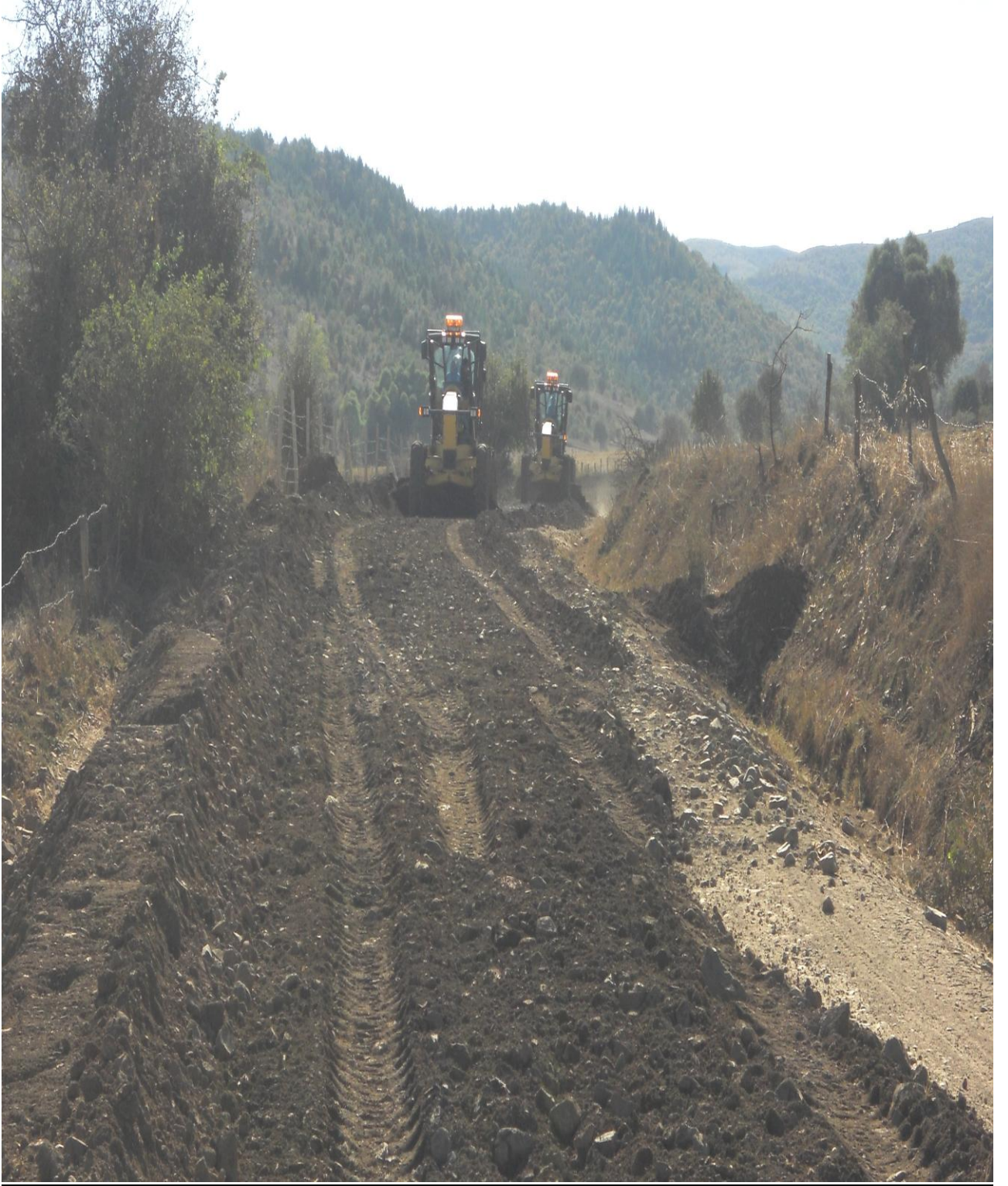
STABİLİZE YOL ÇALIŞMASI
