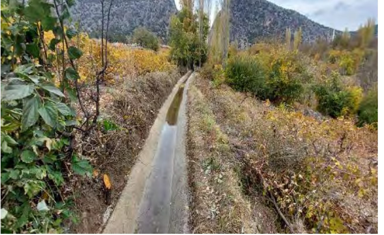
Osmancık İlçesi İnal Köyü Sulama Tesisi
