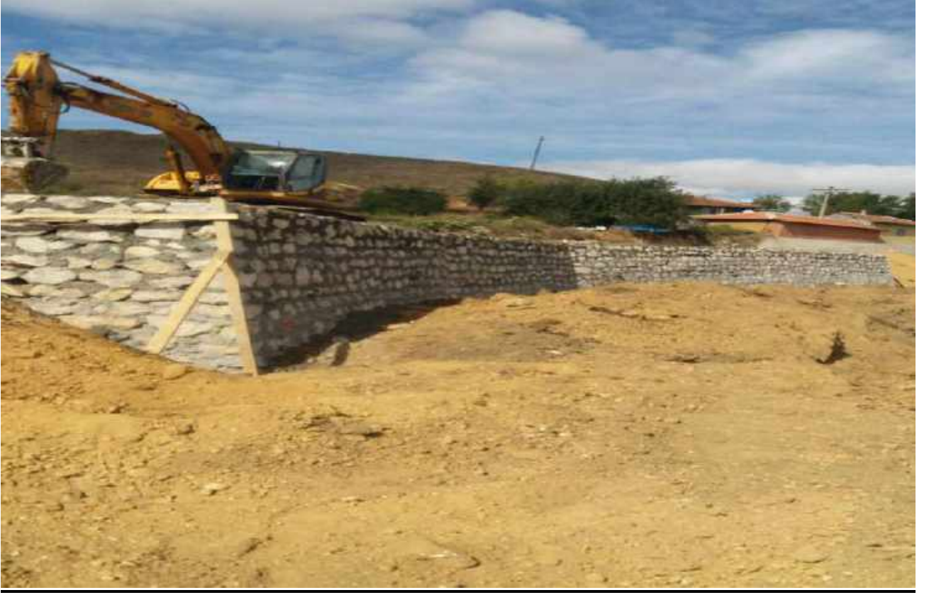
Mecitözü İlçesi Tanrıvermiş Köyü İstinat Duvarı
