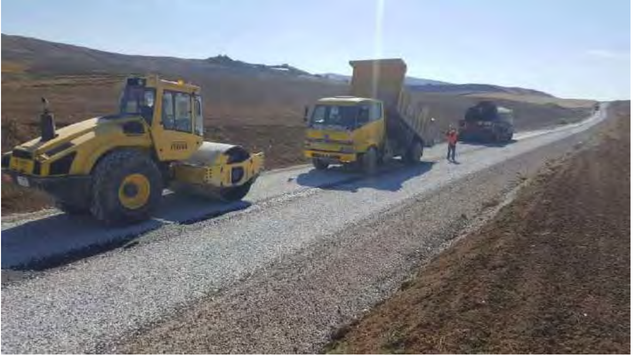
Sungurlu Alembeyli Grup Köy Yolu Asfalt Yapımı
