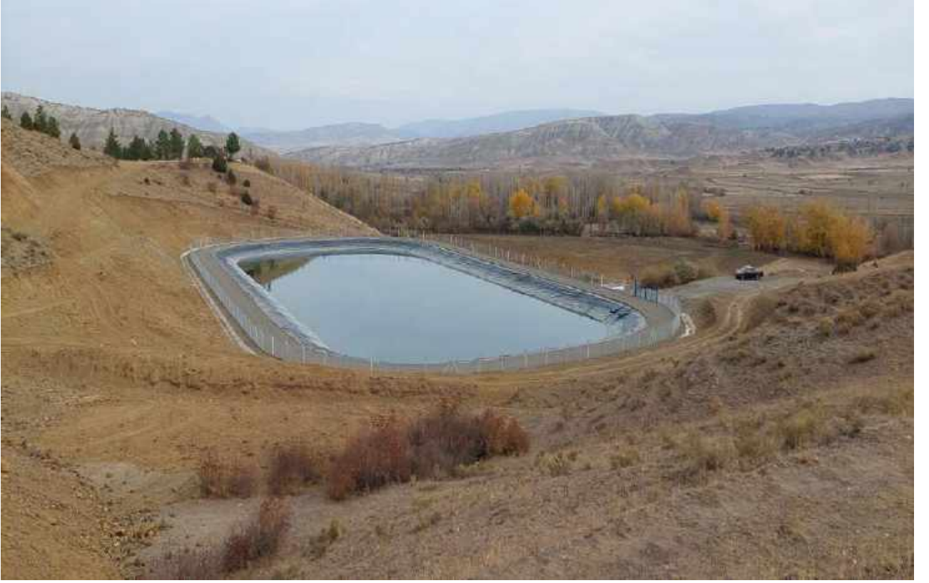
Merkez İlçe Hacıahmetderesi Köyü Membran Kaplamalı Sulama Göleti
