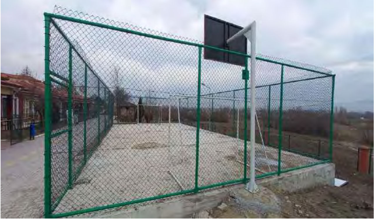
Engelsiz Yaşam Rehabilitasyon ve Aile Danışma Merkez Müdürlüğü Oyun Alanı
