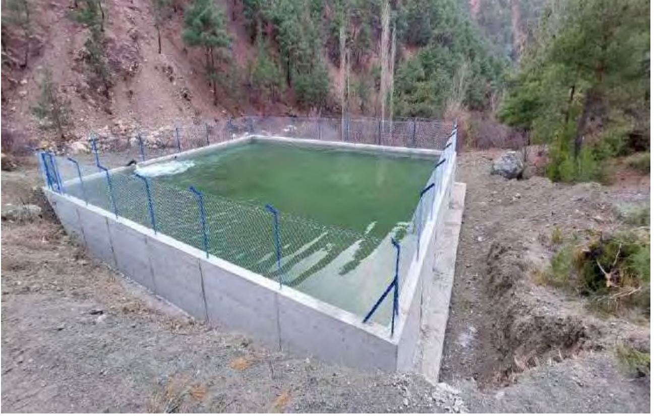
Osmancık Pelitcik Köyü Sulama Havuzu
