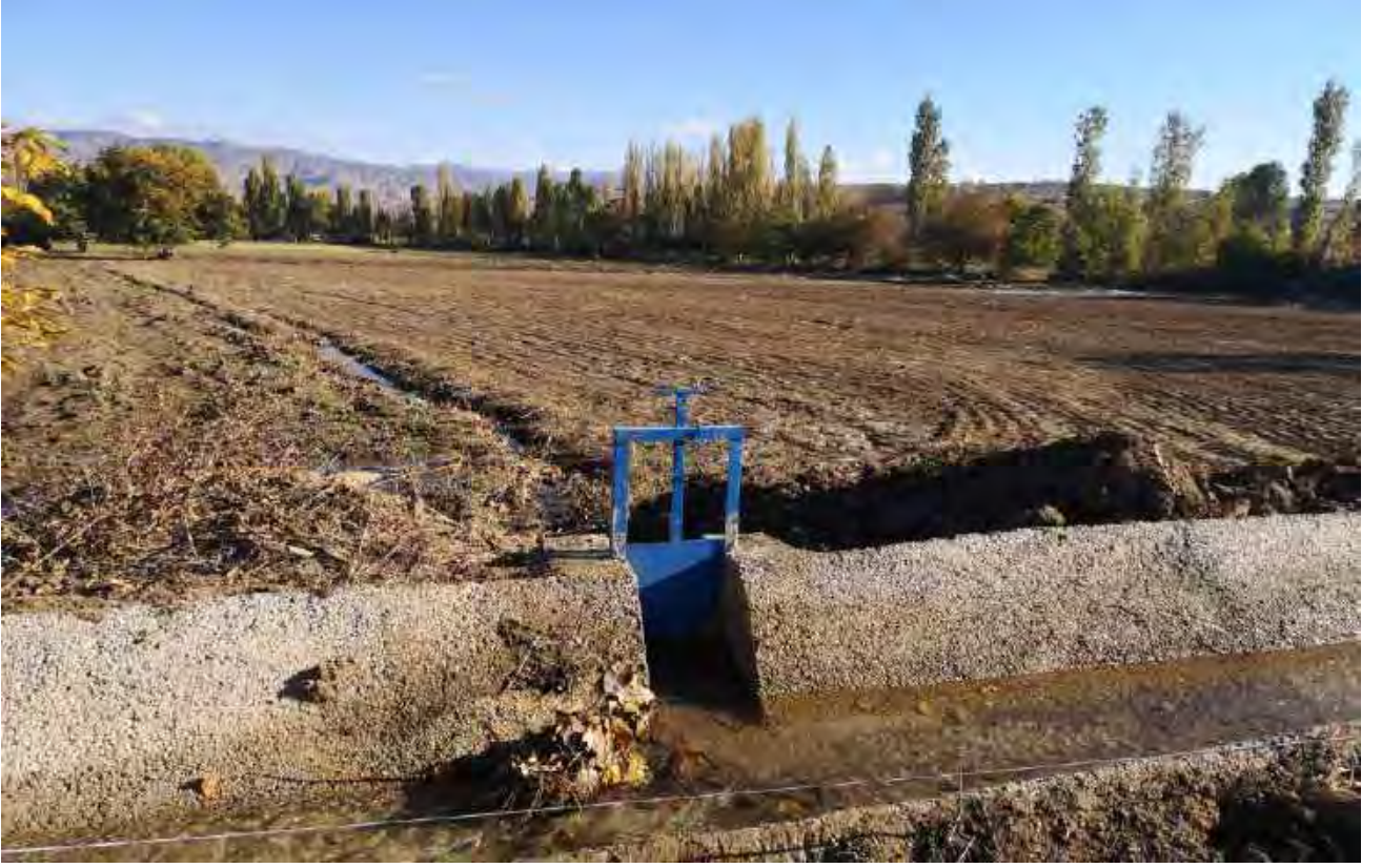
Laçın İlçesi Çamlıca Köyü Mescitli Sulama Tesisi
