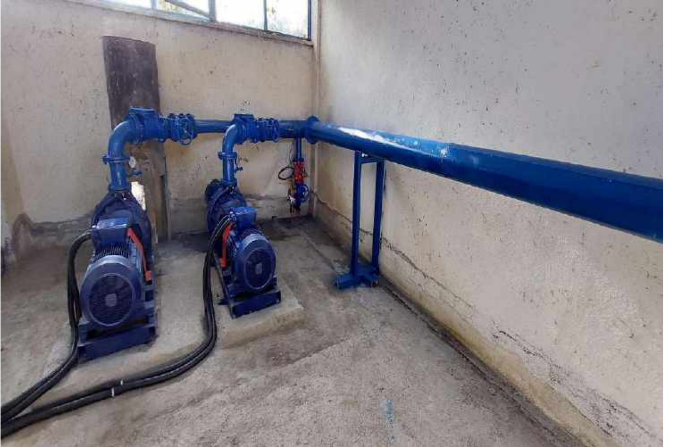
Kargı İlçesi Pelitcik Köyü Devrez Sulama Tesisi
